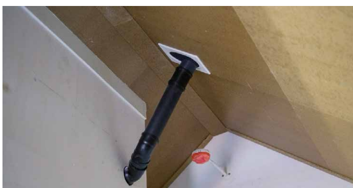
Voorbeeld: een dakdoorvoer-inpandig
