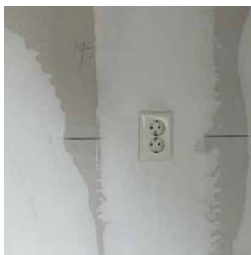
Voorbeeld: behangklare muur (wandcontactdozen verticaal aangebracht);
