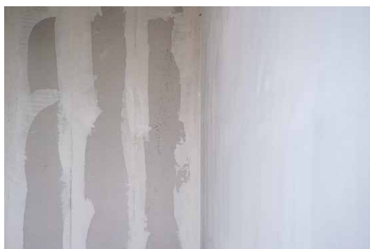
Voorbeeld: behangklare muur (wandcontactdozen verticaal aangebracht);
